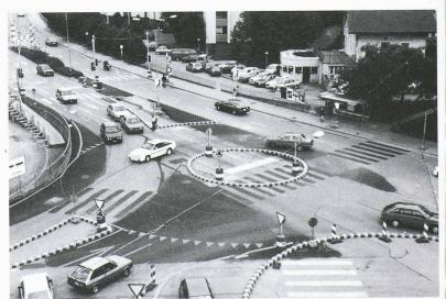
Fig. 13. - Giratoire d'essai ou de chantier.
