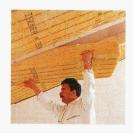
Les feuilles de Flammex N posées, il ne reste plus qu'à assurer l'étanchéité entre les lés et les autres éléments de la construction au moyen des bandes butyliques ISObutyl.
