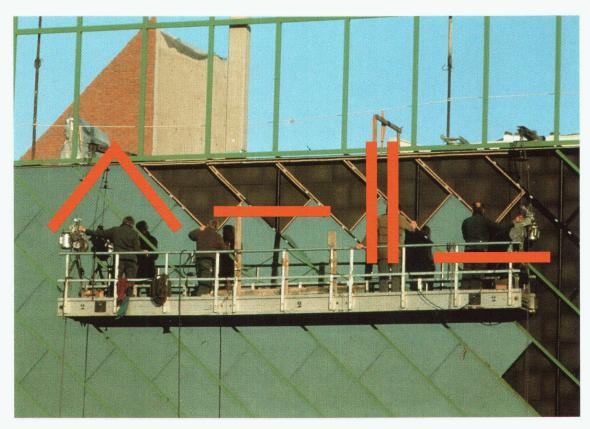
FOAMGLAS®-T5 et FOAMGLAS®-WALL BOARD sont des produits spécialement développés par Pittsburgh Corning pour l'isolation sous bardage ou en double mur. (Photo ci-dessus: façade d'un centre commercial réalisée en verre teinté et isolée à l'aide de plaques FOAMGLAS®-T5).
