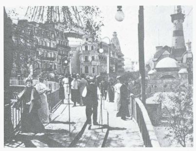
Fig. 2. – Trottoir roulant de l'Exposition universelle de Paris en 1900 (à gauche, plate-forme à 6 km/h; au centre, plate-forme à 3 km/h)
