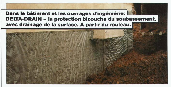
Couche 1: les excroissances tournées vers l'ouvrage séparent sûrement et durablement le mur du soubassement du sol humide, assurent une meilleure isolation thermique et protègent la couche d'étanchéité.
