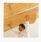
Les feuilles de Flammex N posées, il ne reste plus qu'à assurer l'étanchéité entre les lés et les autres éléments de la construction au moyen des bandes butyliques ISObutyl.
