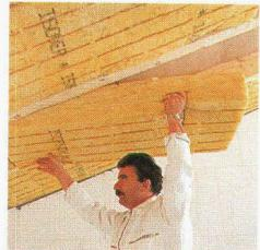
Les feuilles de Flammex N posées, il ne reste plus qu'à assurer l'étanchéité entre les lés et les autres éléments de la construction au moyen des bandes butyliques ISObutyl.
