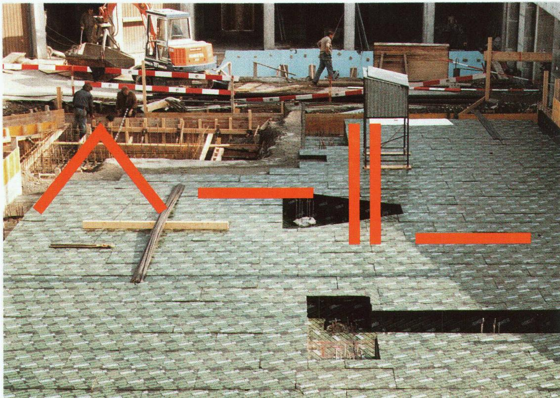
FOAMGLAS®-FLOOR BOARD est un produit spécialement développé par Pittsburgh Corning pour la pose à sec en isolation de sols. (Photo ci-dessus: Pose de FOAMGLAS®-FLOOR BOARD sous le radier d'un immeuble d'habitation.)
