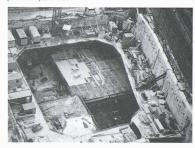
Fig. 6. – Chantier en juillet 1990. Anneau de compression, 1<sup>re</sup> étape
