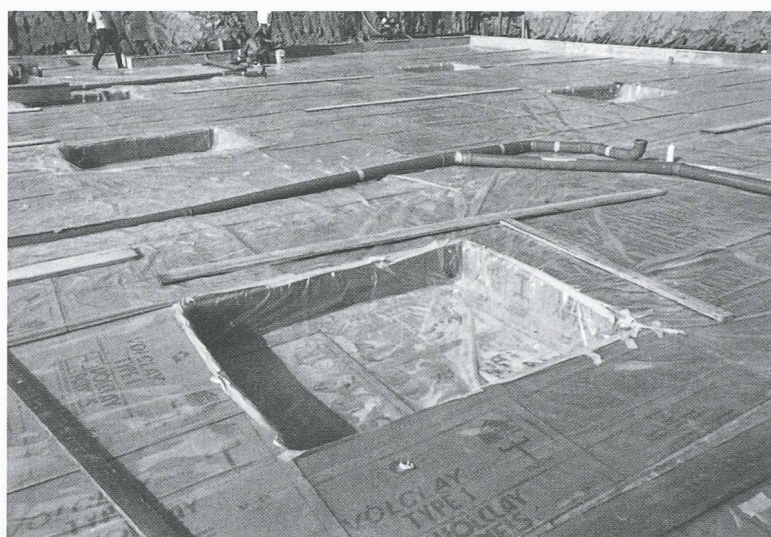
Etanchéité d'une grande fouille avec des panneaux Volclay
