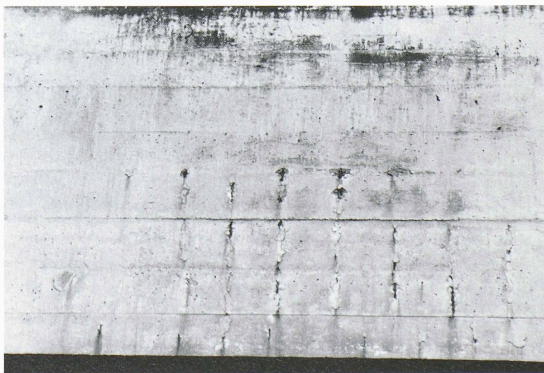
Fig. 1. – Effet de la carbonatation lorsque l'enrobage des armatures est insuffisant.
