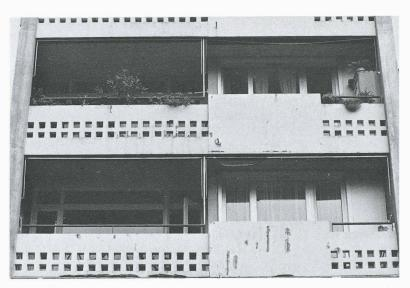
Fig. 4. — Parapets de balcon dégradés par la corrosion des armatures situées en zone carbonatée
