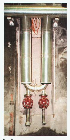
ue de détail d'un poste d'extinction dans sa construction brute. On voit distinctement les conduites d'alimentation déjà isolées ainsi que les deux vannes revêtues électrostatiquement à l'intérieur et à l'extérieur de résine époxyde (EKB), GGG-40, de SCHILLING.
