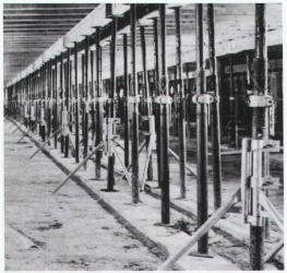
Nüssli-Construvit – un concept pour des étais métalliques et étrésillons robustes et pratiques.
