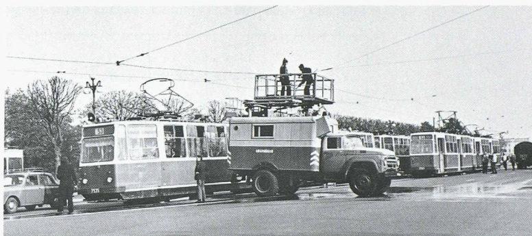
Incident d'exploitation en période de pointe vespérale en mai 1979 sur un tronçon très fréquenté à cinq lignes sur le Prospekt (avenue) Kirow. Le fil de contact d'environ 85 mm 2 à l'état de neuf, très usé, s'est cassé et a provoqué une salade de pantographes. Quelques minutes plus tard la tour de la ligne aérienne était sur place pour «rapprendre» les deux bouts de fil. Tout à droite, le camion dépanneur se prépare à remorquer d'un coup les 38 t des deux automotrices LM68. En 20 minutes, l'accumulation des tramways atteindra une vingtaine de rames par sens.
