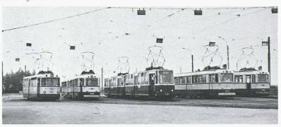
La croissance continuelle du trafic et l'obligation d'augmenter la capacité amène Leningrad depuis quelques années à utiliser une solution déjà éprouvée, observée en 1970 à Kiew: les trolleybus en double traction offrant 220 places par train routier. Seules les perches du deuxième véhicule — mené —, sont levées, le premier — menant —, est alimenté par câble par le second. Un système d'accouplement avec levier et excentrique assure le «guidage» de l'essieu directeur du véhicule mené.
