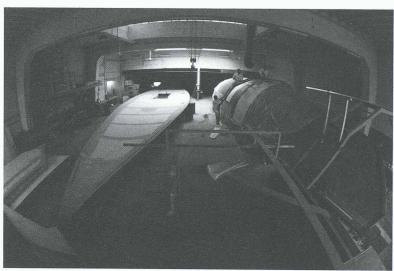
Le pont est fabriqué selon la même méthode à côté de la coque, avant d'être assemblé à celle-ci.
