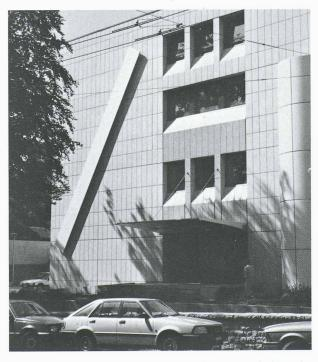
Centre de télécommunications de Neuchâtel. Le panneau de décoration construit par Décision SA mesure 13 m de long et 1 m de large. Il se compose de plaques d'aluminium collées sur du nid d'abeille alu de 10 cm; son poids est inférieur à 200 kg. Il est monté sur des silentblocs, afin d'éviter les vibrations
