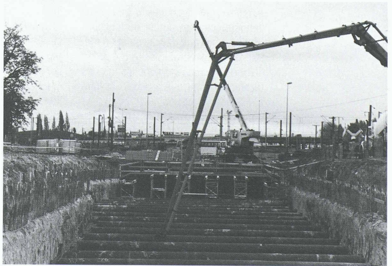
Fig. 8. – Réalisation d'un des trois caissons couverts dont l'un sera réservé aux trains qui passeront sans s'arrêter à des vitesses approchant les 200 km/h.
