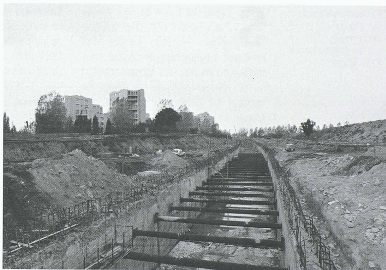
Fig. 8. — Réalisation d'un des trois caissons couverts dont l'un sera réservé aux trains qui passeront sans s'arrêter à des vitesses approchant les 200 km/h.
