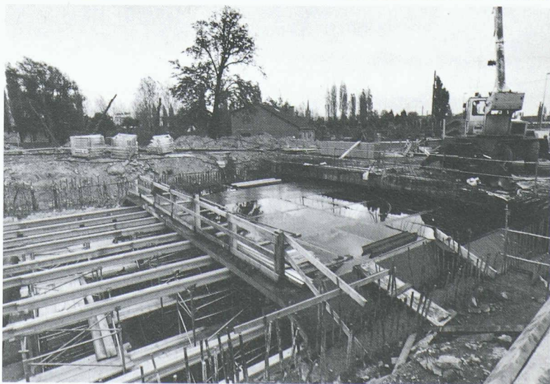
Fig. 9 et 10. — Travaux de bétonnage à l'aide de coffrages se déplaçant sur rails.
