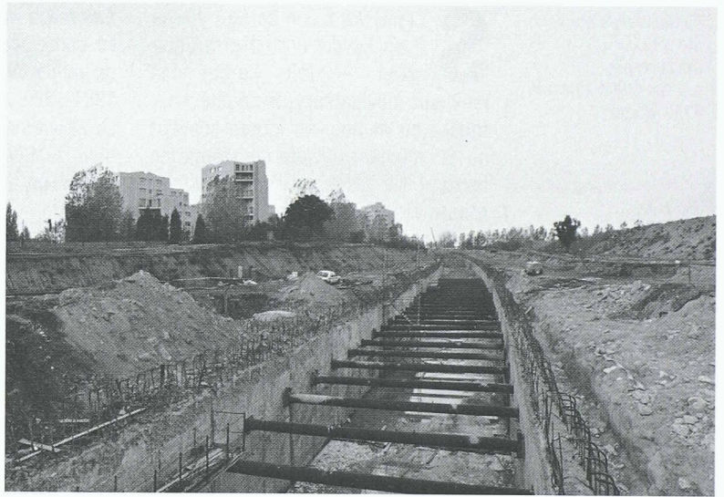
Fig. 8. – Réalisation d'un des trois caissons couverts dont l'un sera réservé aux trains qui passeront sans s'arrêter à des vitesses approchant les 200 km/h.
