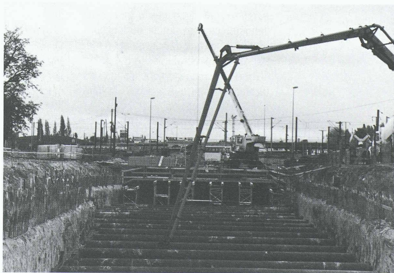
Fig. 8. — Réalisation d'un des trois caissons couverts dont l'un sera réservé aux trains qui passeront sans s'arrêter à des vitesses approchant les 200 km/h.
