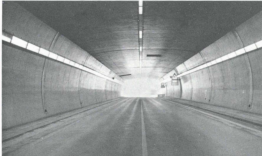
Le tunnel du Klamm sur la route de Gastein en Autriche.
