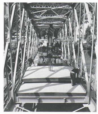
Fig. 11. - Montage du tablier métallique.
