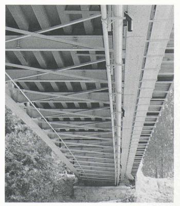
Fig. 12. - Dessous du pont avec tablier métallique.
