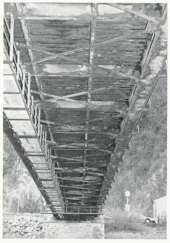
Fig. 6. - Dessous du pont rouillé.
