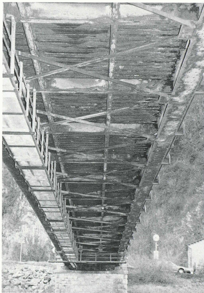
Fig. 6. - Dessous du pont rouillé.
