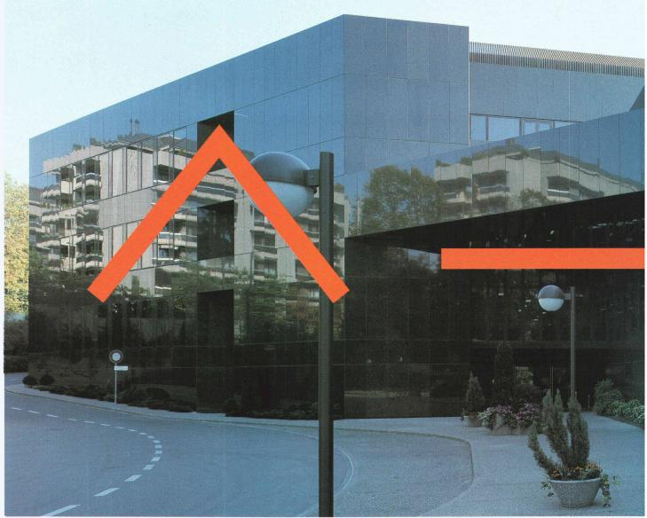
5500 m² de FOAMGLAS® pour l'isolation de toute l'enveloppe du bâtiment. 1500 m² de FOAMGLAS® en façade agrafée. 2000 m² de FOAMGLAS® pour l'isolation des toitures plates et terrasses. 1000 m² de FOAMGLAS® pour l'isolation périmétrique. 1000 m² de FOAMGLAS® pour l'isolation des sols.
