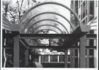
Claire ou fumée, telle se présente la solution légère et élégante pour la couverture de puits de lumière, d'entrées, d'abris, etc. Avec sousconstruction et montage, directement d'usine. Variante en polycarbonate résistant aux chocs ou coupoles en polyester (teintes à choix). COLASIT SA, Fabrique d'appareils en matière plastique Case postale 85, CH-3700 Spiez
