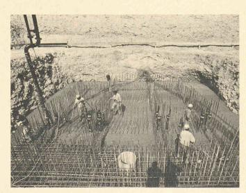
Le massif en béton comprend deux parties: la plaque de béton inférieure mesure  $8,5 \times 8,5 \times 0,8$  m, la plaque supérieure  $3,5 \times 3,5 \times 1,8$  m, ce qui représente un poids de 200 t environ et  $80 \text{ m}^3$  de béton.
