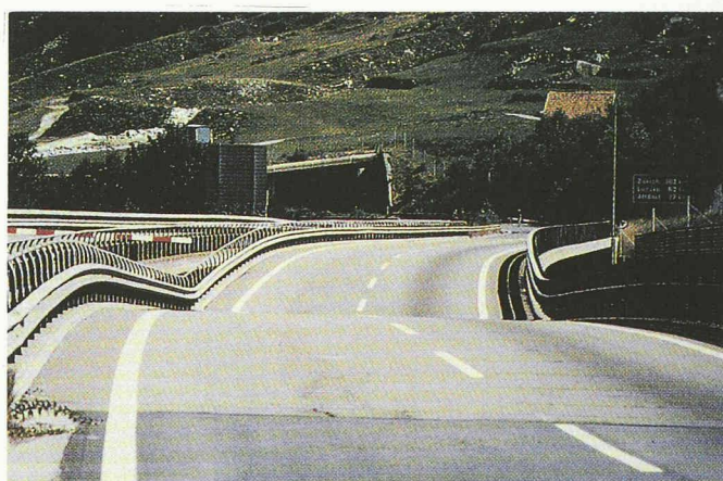
Fig. 3. – Superstructure déformée. (Photo T. R. Schneider.)
