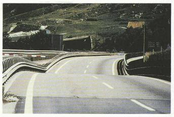
Fig. 3. - Superstructure déformée.
