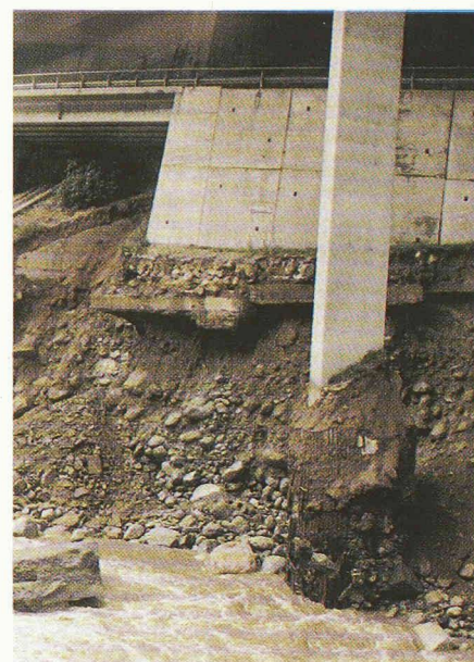
Fig. 6. – Puits de fondation affaissé, pile J vue du nord et le mur de soutènement/culée affouillés du viaduc de la route cantonale. (Photo: T. R. Schneider, 1877/19A.)
