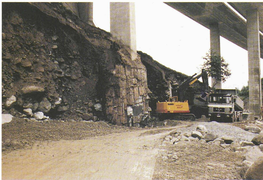
Fig. 11. - Remblayage du puits de fondation de la pile J et mise en place du corps d'appui pour le mur de soutènement.
