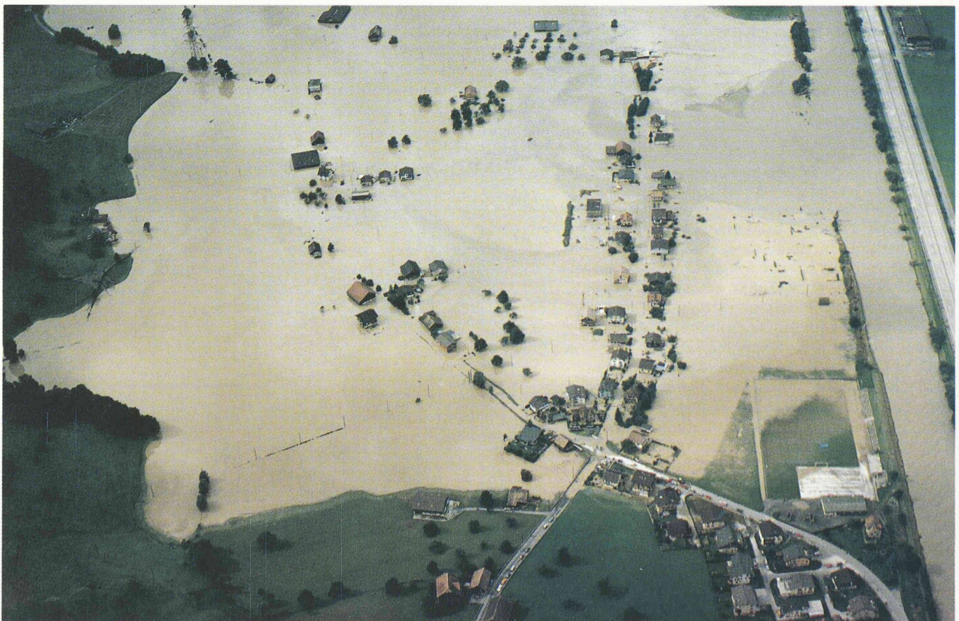
Fig. 2. – Rupture de la digue à Attinghausen, photo du 25 août 1987.
