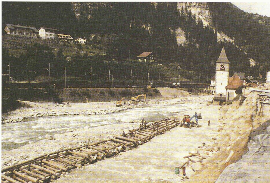
Fig. 4. – L'église de Gurtellen, au premier plan la route du Saint-Gothard détruite, construction de parois « Krainer ». (Photo Office des Travaux publics d'Uri.)
