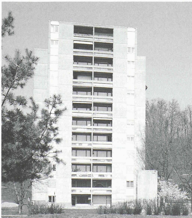
A gauche : tour d'habitation à Glattbrugg avant la remise en état de 1988. La façade présente le type de construction usuel dans les années 70 : béton apparent et isolation intérieure.
