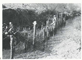
Fig. 8. – Protection par fascines. (a) La réalisation des constructions végétales nécessite des personnes compétentes comme dans toute construction (30.3.1989). (b) La grande niche d'érosion a été activement protégée par un mur de fascines complété par des sacs de géotextiles (8.4.1989). (c) Les végétaux offrent un « mur » inattaquable et une diversité biologique remarquable. Le cours d'eau ressemble à une rivière naturelle (7.9.1990).
