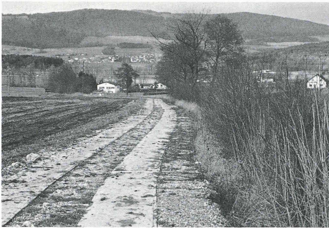
Fig. 5. - Remaniement parcellaire de Bassecourt: chemin en pente de 7 à 8% avec bande de roulement, construit en 1989 (photo 1991).
