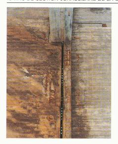
Fig. 2. - Vue du joint de dilatation.
