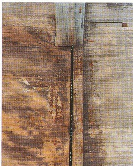
Fig. 2. - Vue du joint de dilatation.
