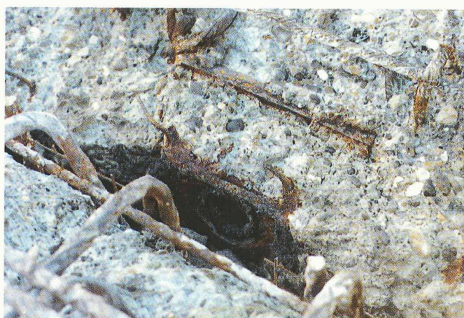
Fig. 5. – Têtes d'ancrages.
