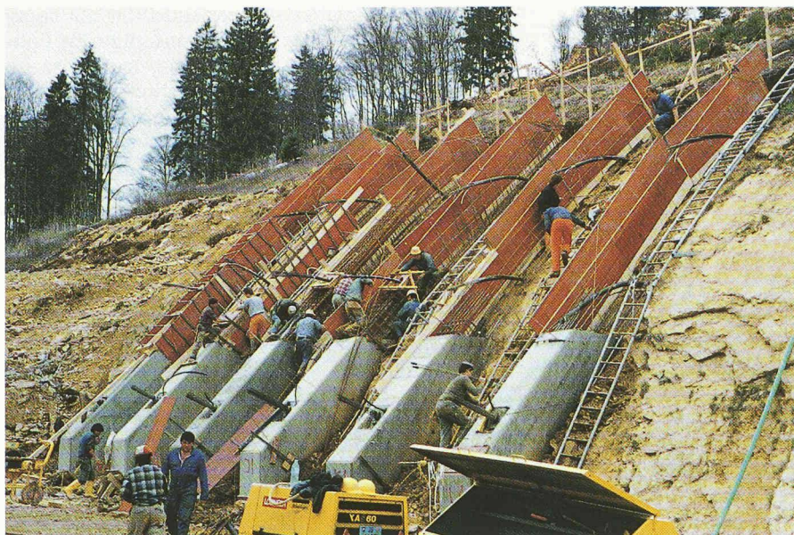
Fig. 5. – Côté Saint-Brais: contreforts.
