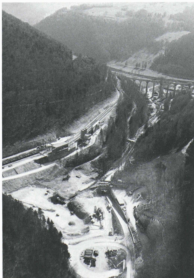
Fig. 1 (en haut à gauche). – Une géographie provisoirement malmenée. Situons le chantier: en haut, Cornol; à gauche, les méandres de l'Allaine. La ligne de chemin de fer de gauche, ligne CJ à voie normale, conduit de Porrentruy à Bonfol. Celle de droite, propriété des CFF, rejoint Delémont. Elle sera déplacée sur 1500 m et accolée à la voie CJ. La Transjurane débute actuellement: extraction, concassage, réalisation de la digue CFF. Dans ce secteur du Noir Bois, la nappe phréatique alimentant Porrentruy est mise sous protection, d'où un ensemble de mesures techniques appropriées qui éviteront toute pollution provoquée par le trafic autoroutier.
