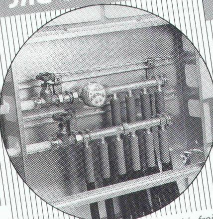
Le système d'installation d'eau potable froide
