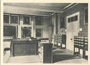
Ecole des garçons de Winterthour: les frères Sulzer y installèrent en 1841 leur premier chauffage central à vapeur basse pression; on aperçoit à l'arrière-plan les corps de chauffe à deux tubes.
