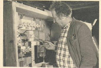
L'électricien vient d'installer le disjoncteur F1 dans son boîtier de sécurité.
