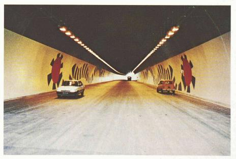
Fig. 12. – Décor sobre dans un long tunnel droit pour rompre la monotonie.
