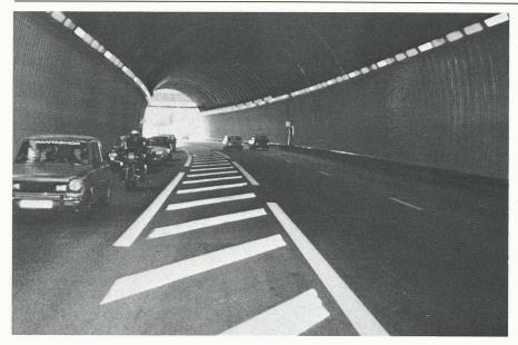
Fig. 9. - Séparation des voies dans un tunnel bidirectionnel.
