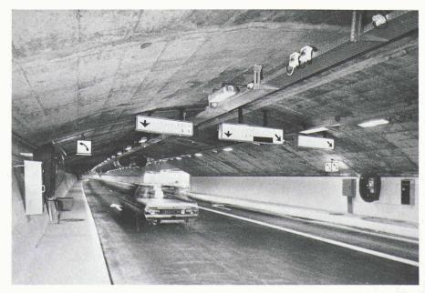
Fig. 8. - Panneaux de signalisation aux dimensions réduites.
