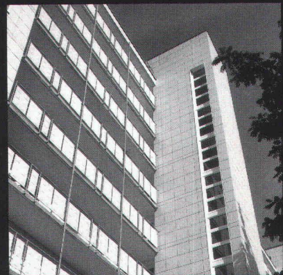
Logements Grosswiesenstrasse, Zurich (Caisse de Pension HG Commerciale, Zurich)
