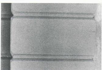
Fig. 2, 3. – Un chaînage avant et après nettoyage à l'eau pure sans pression ; les croûtes chargées de matières polluées ont disparu, rendant l'intervention mécanique inutile.
