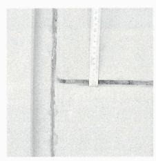
Fig. 4, 5. – La suppression du joint intact (6 mm) a entraîné un écartement des arêtes et le joint a perdu de sa finesse (12 mm).
