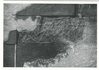
Fig. 10. – Crépissage chaux-trass (sable)-ciment: au milieu la pierre de taille dégradée (consolidation avec une armature de fil de fer préparée d'avance); en bas un enduit de mortier grossier, en haut une surface à grain serré (avant la mise en œuvre du traitement de surface).
