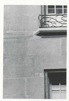
Fig. 12. – Tablette de fenêtre remplacée par une pièce en pierre naturelle et intégrée dans une façade uniquement nettoyée, non restaurée.
