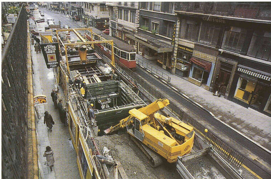
Fig. 6. – Organisation «compacte» du chantier: travaux d'excavation suivis du bouclier, du dispositif de bétonnage et de la fermeture de la fouille. Le trafic est maintenu sur les deux trottoirs et sur une partie de la chaussée avec une voie provisoire du tram.
