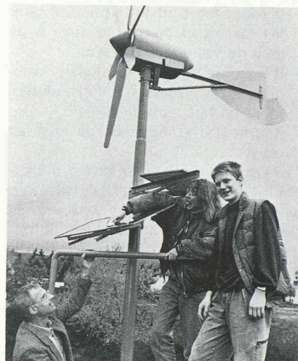
A partir de son toit, une école de Kronberg, près de Francfort-sur-le-Main, alimente en énergie éolienne et héliothermique sa section de sciences naturelles et disciplines annexes. Eolienne et cellules solaires ont été entièrement installées par les élèves et les enseignants de l'établissement.
