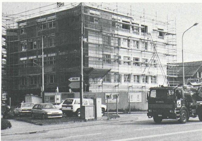
Fig. 4. - L'immeuble en cours de construction, avec isolation extérieure.
