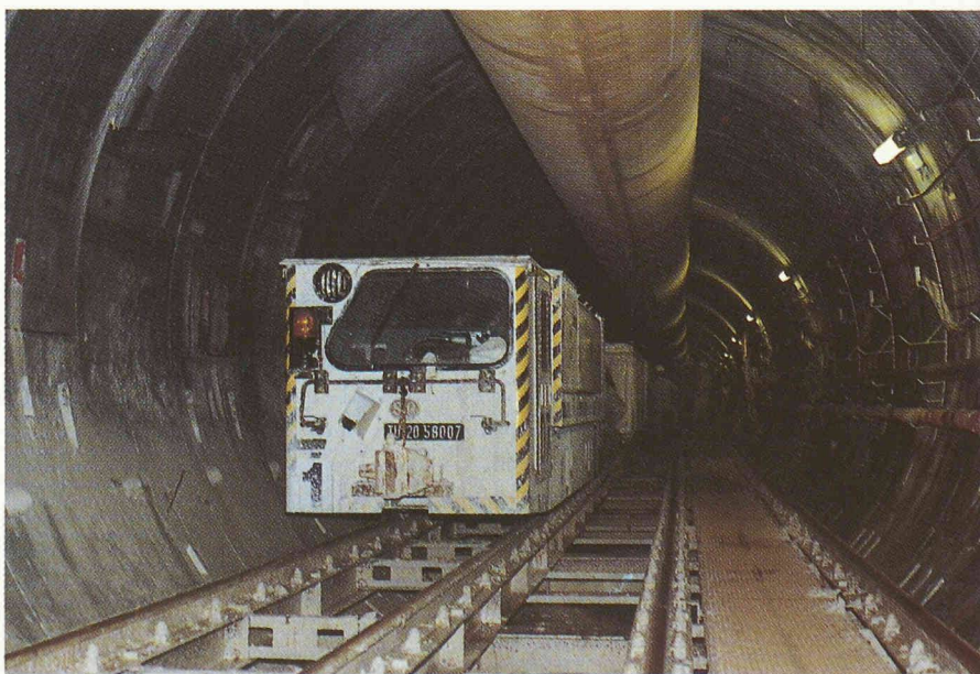
Fig. 10. - Locomotive V20, ici en tête d'un train d'évacuation des matériaux.
