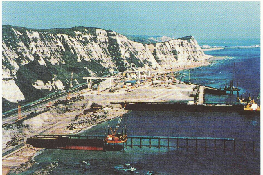
Fig. 14. - Le chantier a démarré à 100 m sous la falaise de Shakespeare Cliff. Les installations de chantier sont établies en surface sur une plate-forme au pied de la falaise, qui gagnera 45 hectares sur la mer par la récupération des déblais du forage.
