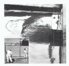
Les produits de revêtement liquides à base de résines artificielles permettent l'application d'étanchéités exemptes de joints en considération des détails. Les raccords sur béton et métal sont faciles et sûrs.
