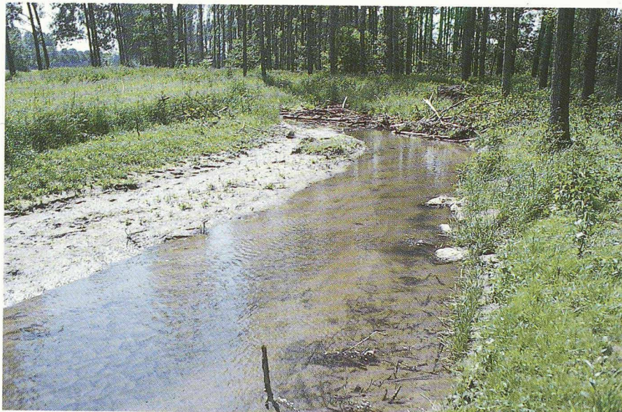
Wieseck. Le nouveau lit est quasiment sans protection ; sur la rive intérieure se forment des alluvions ; l'accumulation de branchages crée des biotopes propres aux cours d'eau.
