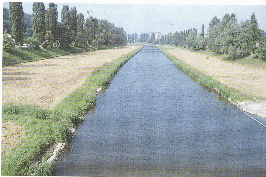
Enz. Dans la zone urbaine de Pforzheim, cette rivière, qui prend ses origines dans la Forêt-Noire, a été canalisée au début du siècle. Ses larges rives devaient être fauchées régulièrement. (Photo Becker.)
