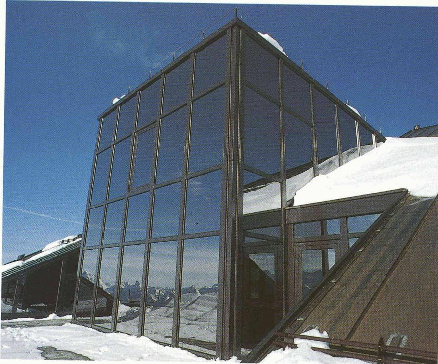
explosion due à la différence de pression entre la plaine et le lieu du chantier, les éléments en verre isolant sont pourvus de plusieurs valves de surpression et contiennent un produit dessicant pour absorber l'humidité qui pourrait pénétrer dans l'espace intercalaire. Transportés à 2000 mètres, les doubles verres sont ensuite rapidement étanchés et brièvement stockés. En quelque cent vingt rotations, l'hélicoptère a acheminé l'ensemble de la façade et sa sous-construction en aluminium.
