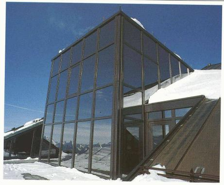
fers de rives. L'ensemble de la sousconstruction a été posée en quatre semaines par quatre monteurs. L'effectif a passé alors à six hommes pour entreprendre la pose des éléments de façade qui a demandé cinq semaines au total.
