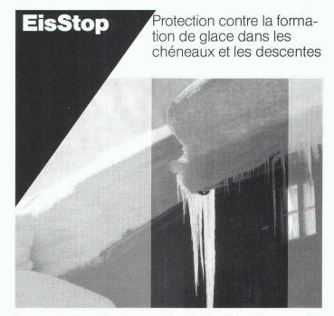
La mauvaise évacuation de l'eau due au dégel de la neige des toits, provoqué par le rayonnement solaire et la chaleur du bâtiment, occasionné de gros dégâts aux installations: descentes éclatées, chéneaux affaissés, siphonnage de la toiture, etc...
