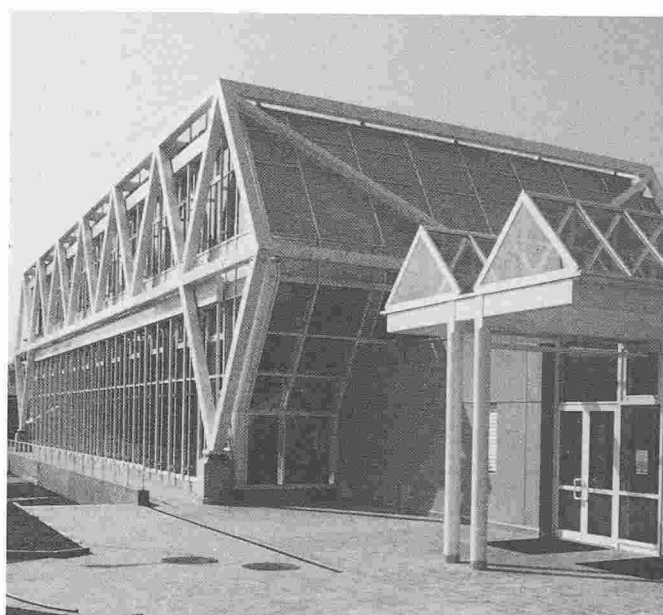
Centre sportif du Bois-des-Frères au Lignon GE (ch. de l'Ecu); maître d'ouvrage: Ville de Genève; architecte: Association d'architectes Groupe 6, Genève.
