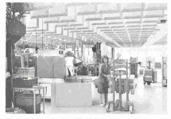
Fig. 10. – Elément absorbant Idikell B 208 suspendu dans une usine.
