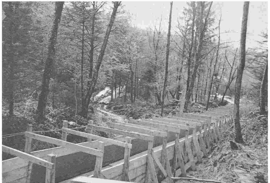
Fig. 3. - Mesure d'urgence, le chenal provisoire.
