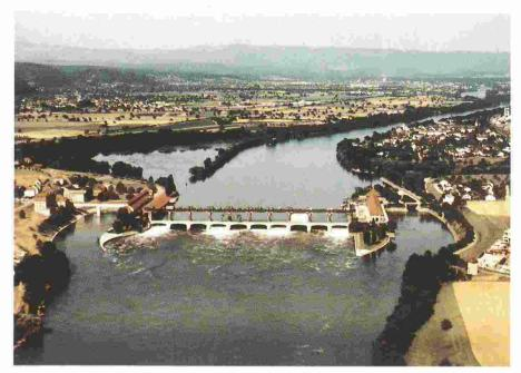
Construction symétrique pour la centrale force-motrice Augst-Wyhlen, rive droite et rive gauche du Rhin. (Photos Sulzer,)
