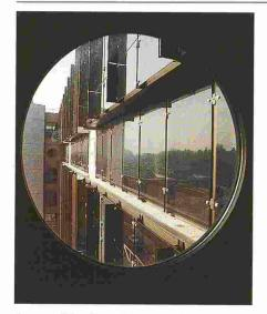
Les profilés d'aluminium cintrés et recuits, vernis au four, forment un élément remarquable de la façade.
