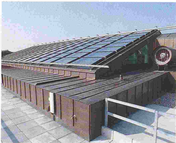
Vue extérieure du vitrage de l'atrium, avec sa double peau système tuiles.
