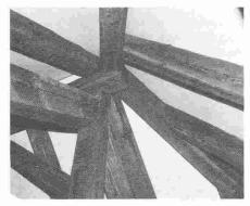
Pour de tels combles, il est pratiquement impossible d'assurer l'étanchéité à l'air nécessaire avec un pare-vapeur et une feuille d'étanchéité à l'air côté intérieur de la structure porteuse.
