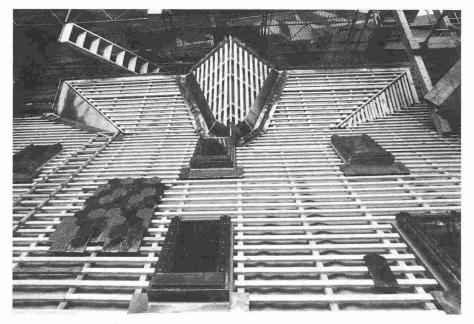
La sous-couverture Sarnatex étanche à l'eau assure une protection durable contre l'eau qui s'infiltre, même sous les anciennes tuiles.
