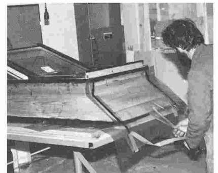
Les fenêtres de toiture complétées d'un cadre intérieur sont équipées en usine de barrière de vapeur (notre illustration), couche d'isolation thermique et sous-couverture sans joint.
