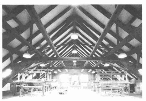
Ferme et grange transformées par l'architecte Werner Schmutz en un centre de loisirs du Spittelhof. Le système de sous-couverture SranaRoof, grâce auquel les activités de loisirs peuvent se dérouler dans un climat ambiant agréable, a été réalisé sur la structure porteuse, qui est ainsi restée apparente.
