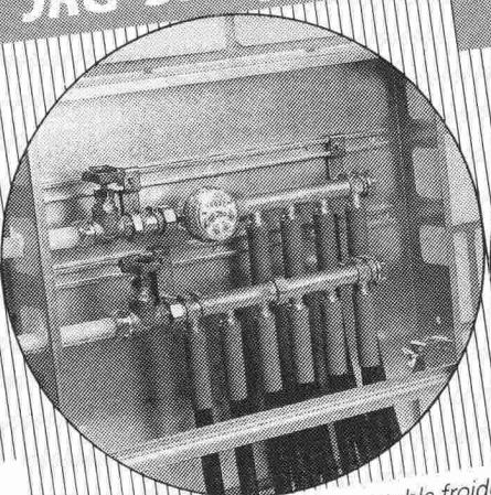
Le système d'installation d'eau potable froide
