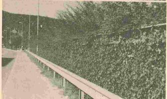
Photo du haut: les éléments de construction en bois dur imprégné en autoclave se montent facilement.
